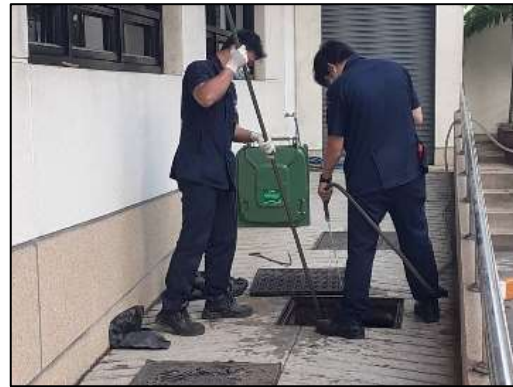
รูปที่ 20 การขุดลอกท่อระบายน้ำ และสูบน้ำขึ้นโดยรอบโครงการ
