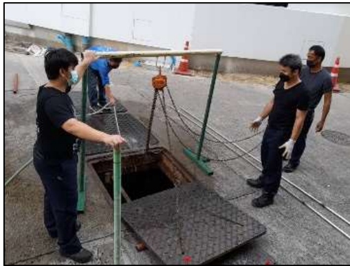
รูปที่ 20 การขุดลอกท่อระบายน้ำ และสูบน้ำขึ้นโดยรอบโครงการ
