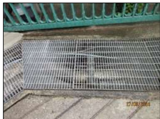
รูปที่ 19 ตะแกรงดักขยะโดยรอบพื้นที่โครงการ
