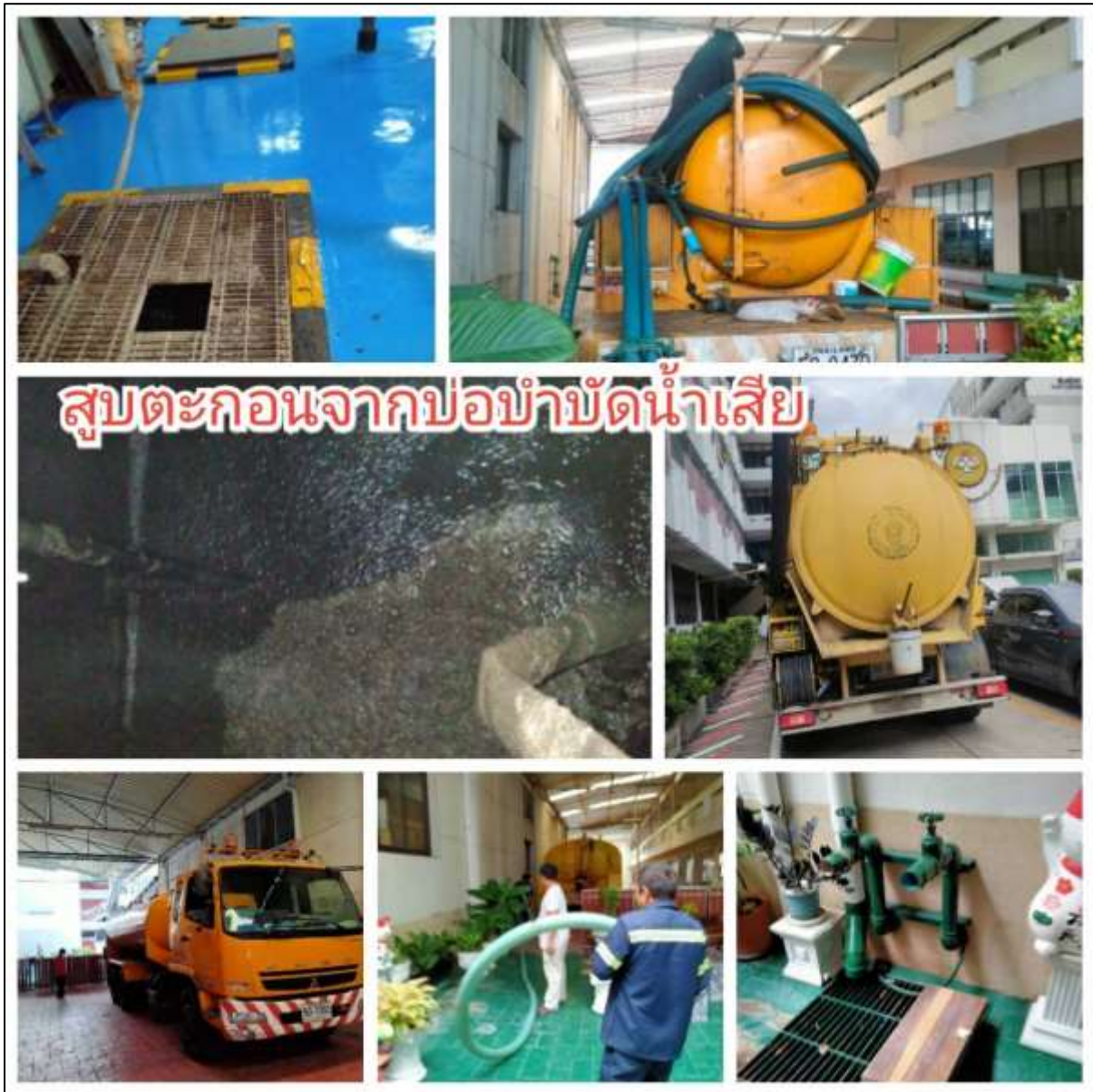
รูปที่ 20 (ต่อ) การขุดลอกท่อระบายน้ำ และสวบตะกอนโดยรอบโครงการ
