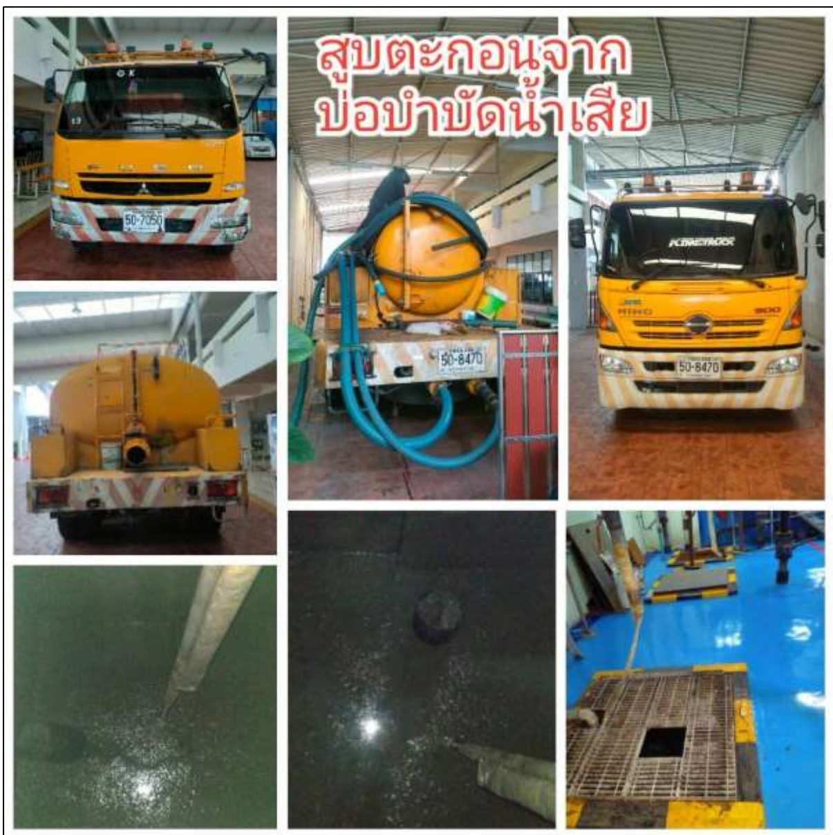
รูปที่ 20 (ต่อ) การขุดลอกท่อระบายน้ำ และสูบน้ำขึ้นโดยรอบโครงการ
