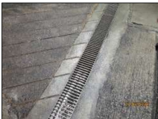
รูปที่ 19 ตะแกรงดักขยะโดยรอบพื้นที่โครงการ
