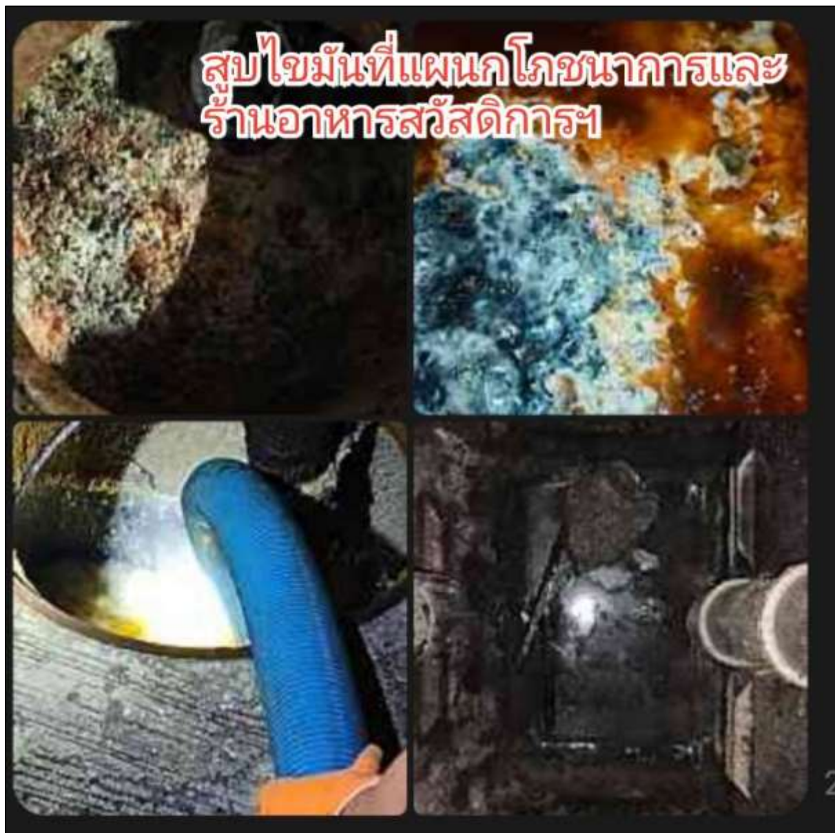
รูปที่ 39 การสบูบไขมันจากบ่อดักไขมัน
