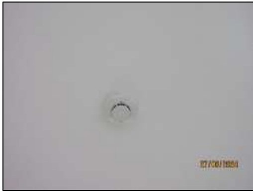
รูปที่ 45 อุปกรณ์ตรวจจับควัน/ความร้อน
